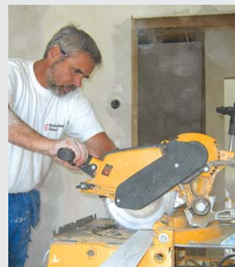
Innenausbau im Dachgeschoss: Profilschalung passgenau zusägen
