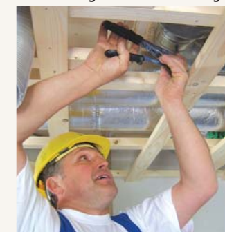
Rohre für die WGT (Lüftungsanlage) verlegen in der Deckenabhängung
