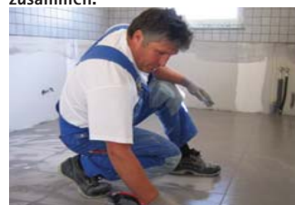
In der Küche werden die groß-formatigen Bodenfliesen verlegt.
