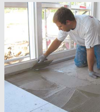
Verkleben der Schallentkoppelungsmatten im Erdgeschoss.
