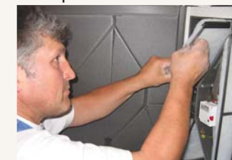
WGT Montage Filtermatten einlegen
