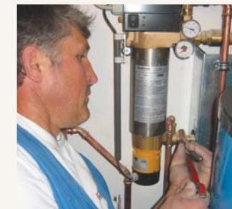
Warmwasserversorgung Pufferspeicher anschließen.
