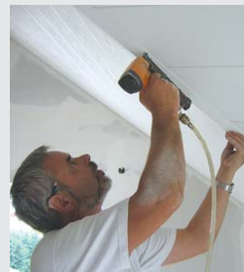
Montage der Profilschalung im Dachgeschoss
